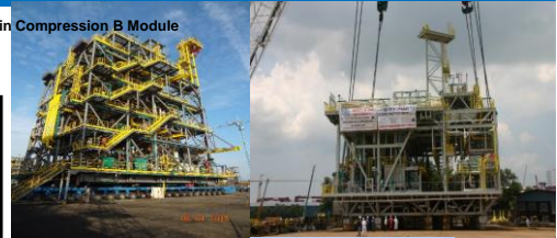
Malampaya Bridge Module
